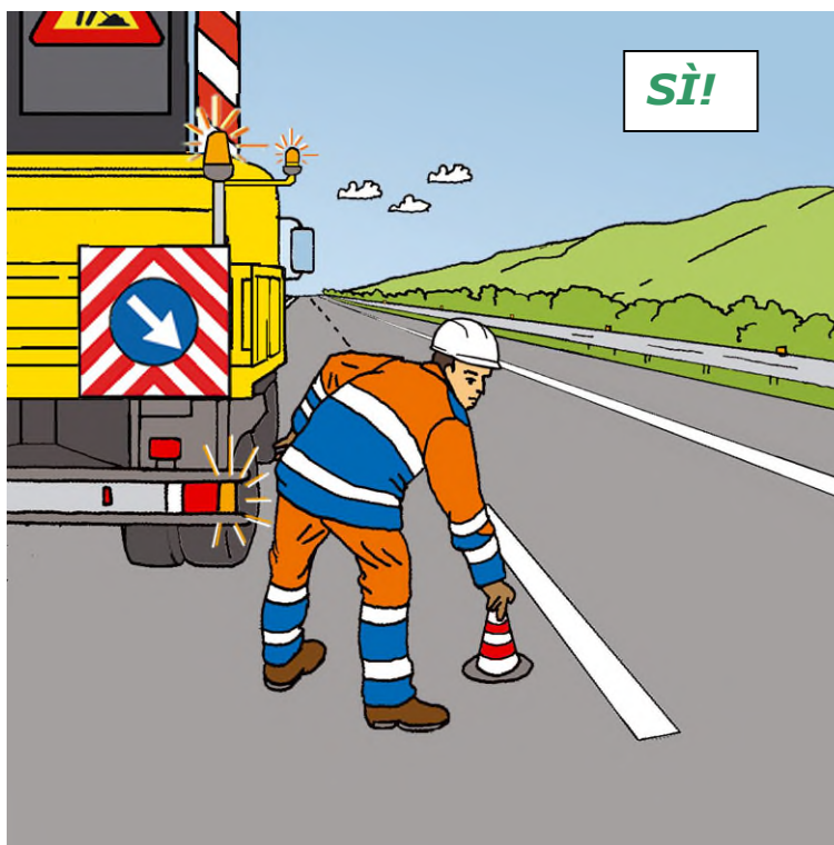
Figura 59 – Posizionamento dei coni o defleco: comportamento corretto
